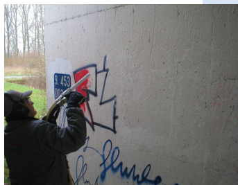
Graffiti-Entfernung und Entlackung
