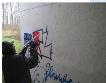
Anti-Graffiti et décapage
