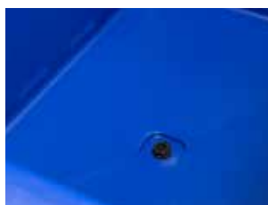
Agujero de drenaje en la parte inferior
